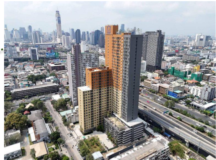
อาคาร D1 (ระยะที่ 2)
